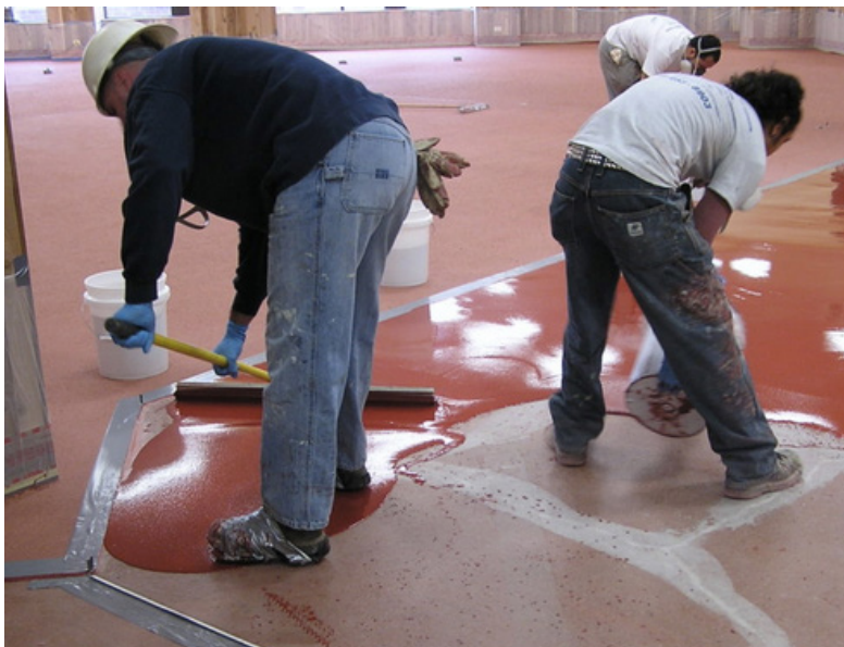
Figura 1. Revestimiento y contención de suelo epoxi.
